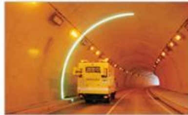
▲トンネル覆工面調査
